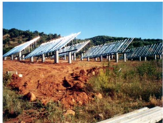
Φωτογραφίες 1 & 2: Υποδομή στήριξης φωτοβολταϊκών κυψελών
