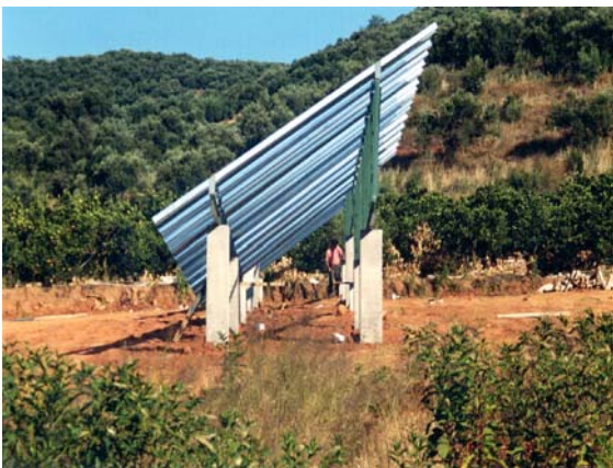
Φωτογραφίες 1 & 2: Υποδομή στήριξης φωτοβολταϊκών κυψελών
